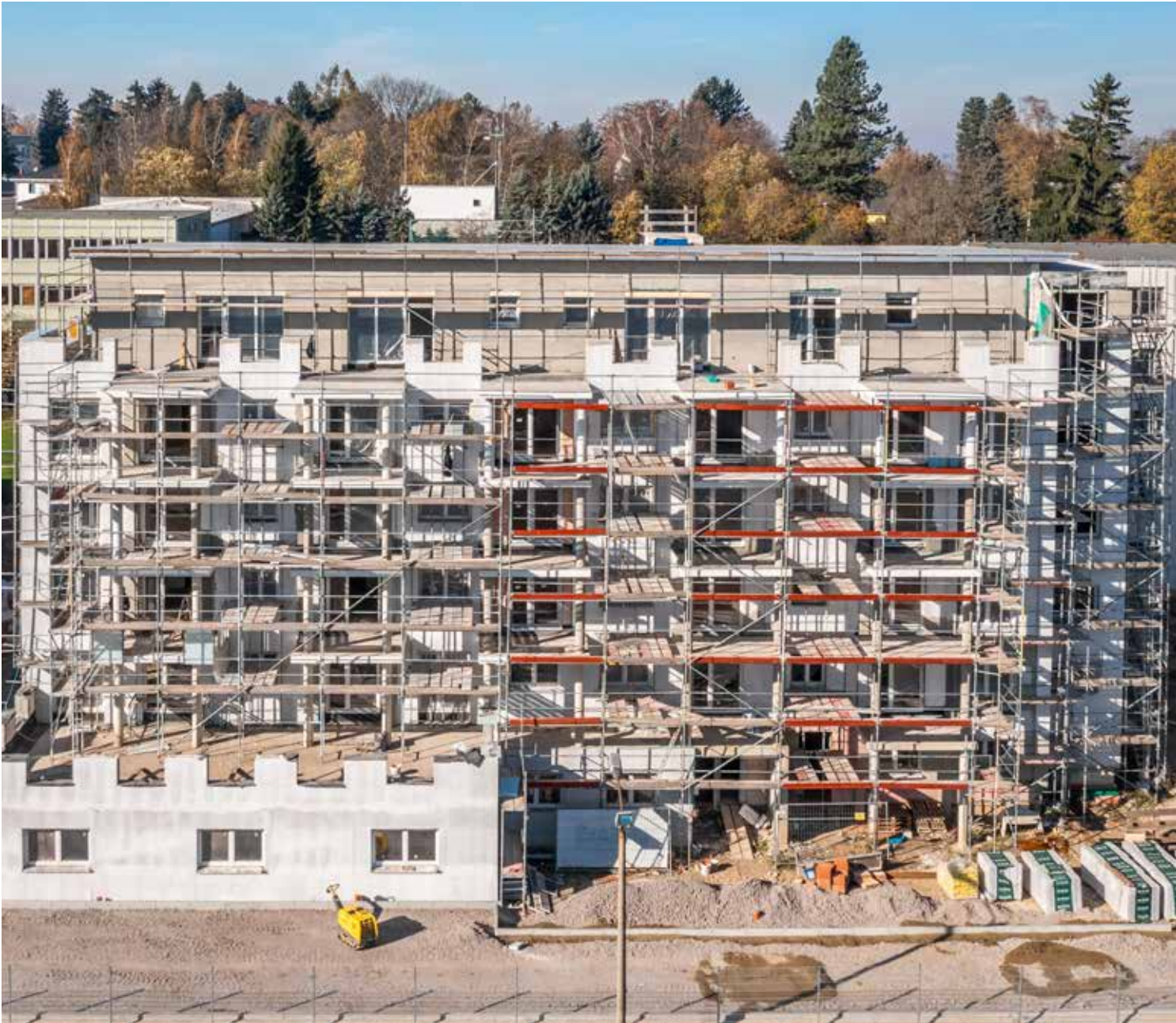
Das Quartier Adelsberg während der Bauarbeiten
